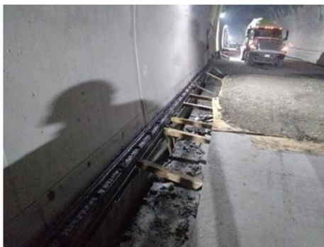
Construcción de cárcamo
