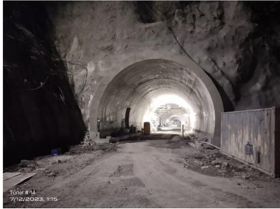
Portal salida túnel 14
