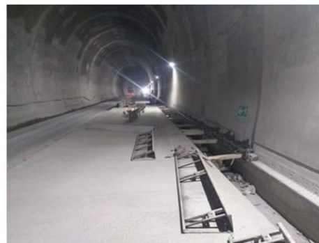
Construcción de cárcamo
