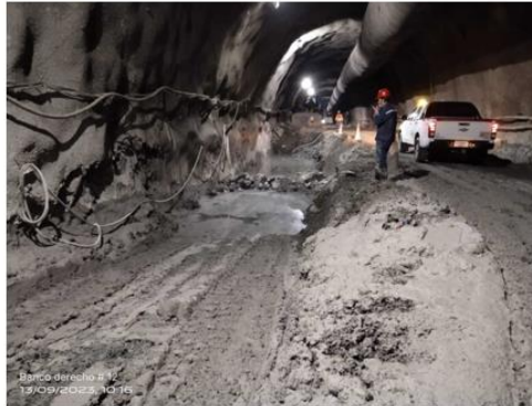
Excavación de bancos Túnel GGE portal Giraldo
