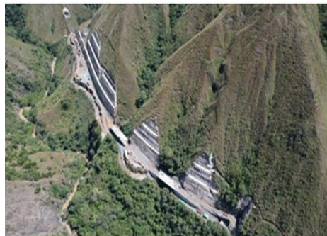
Vista sector puente 10 a túnel 13
