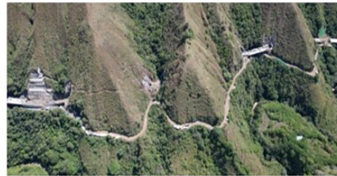
Vista sector túnel 13 a túnel 11
