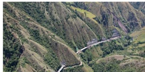
Vista sector túnel 11 a puente 1
